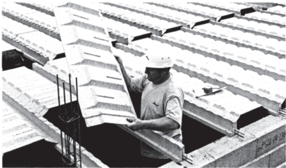
Fig. 20 : Pose d'entrevous entre poutrelles
